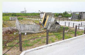
遺構と見学用通路
